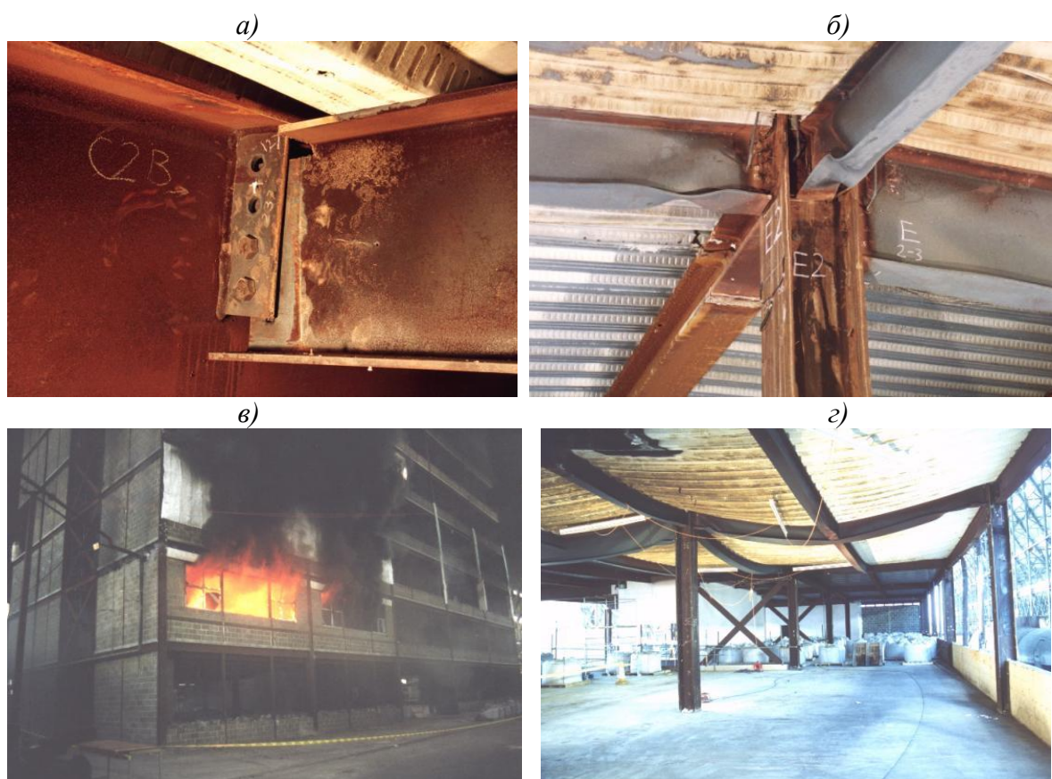
Рис. 2. Испытания стального каркаса в Кардингтоне: а – отказ соединения (тест 2 – испытание плоской рамы); б – потеря местной устойчивости балок (тест 3 – угловое испытание); в – пожар в отсеке (тест 4 – пожар в офисном помещении); г – последствия мембранного эффекта в тесте 4
