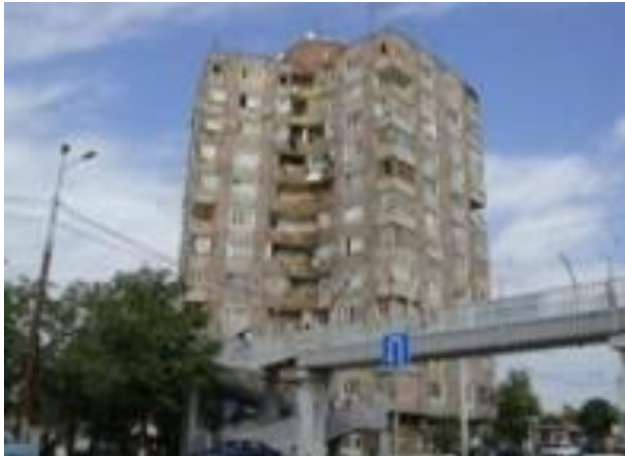
Рис. 5. Здания построенные методом подъема этажей
