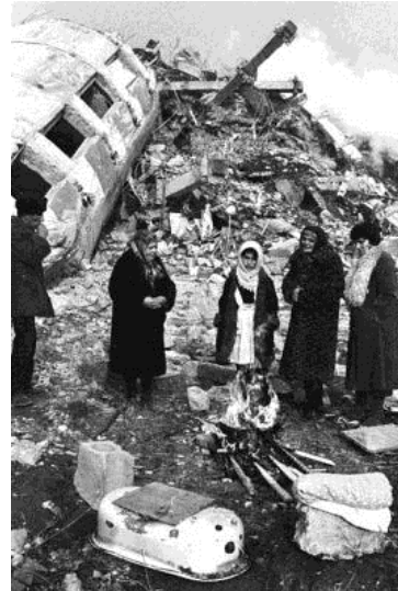
Рис. 5. Здания построенные методом подъема этажей
