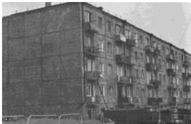
Рис. 2. Девятиэтажное и пятиэтажное крупнопанельные здания с минимальными повреждениями, г. Гюмри, 1988 г.
