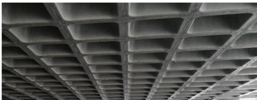
Рис. 1. Внешний вид кессонного перекрытия
