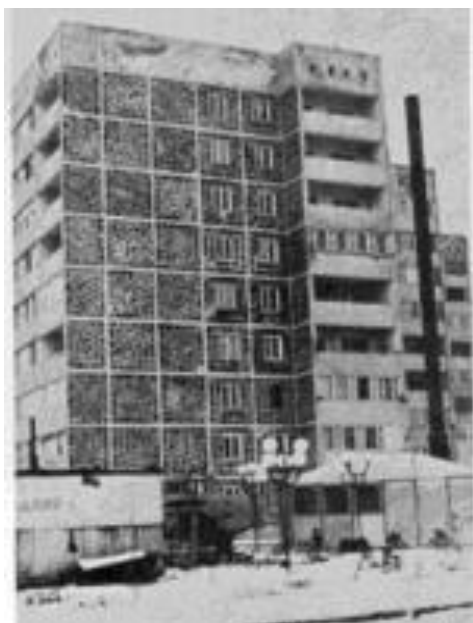
Рис. 2. Девятиэтажное и пятиэтажное крупнопанельные здания с минимальными повреждениями, г. Гюмри, 1988 г.
