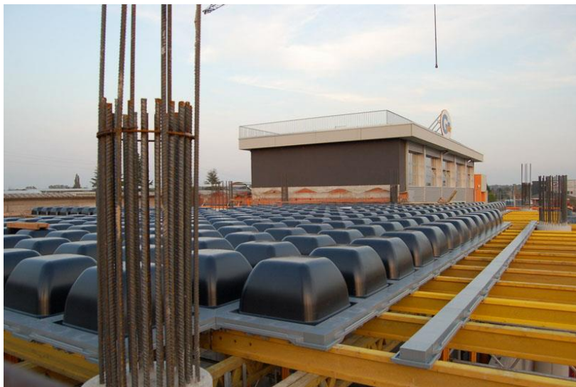
Рис. 3. Укладка пустообразователей
