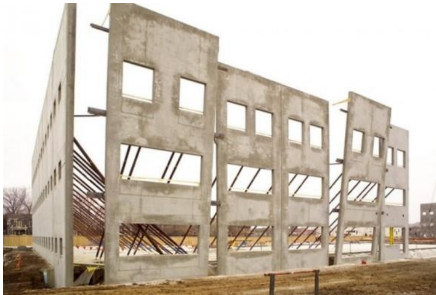
Рис. 1. Технология «Tilt-Up» [1]
