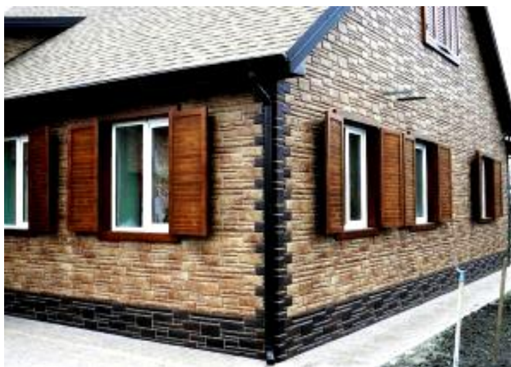
Рис. 2. Облицовка дома искусственными камнями [17]
