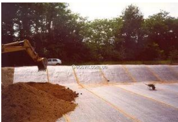
Рис. 2. Укладка противофильтрационного экрана пруда испарителя-накопителя
